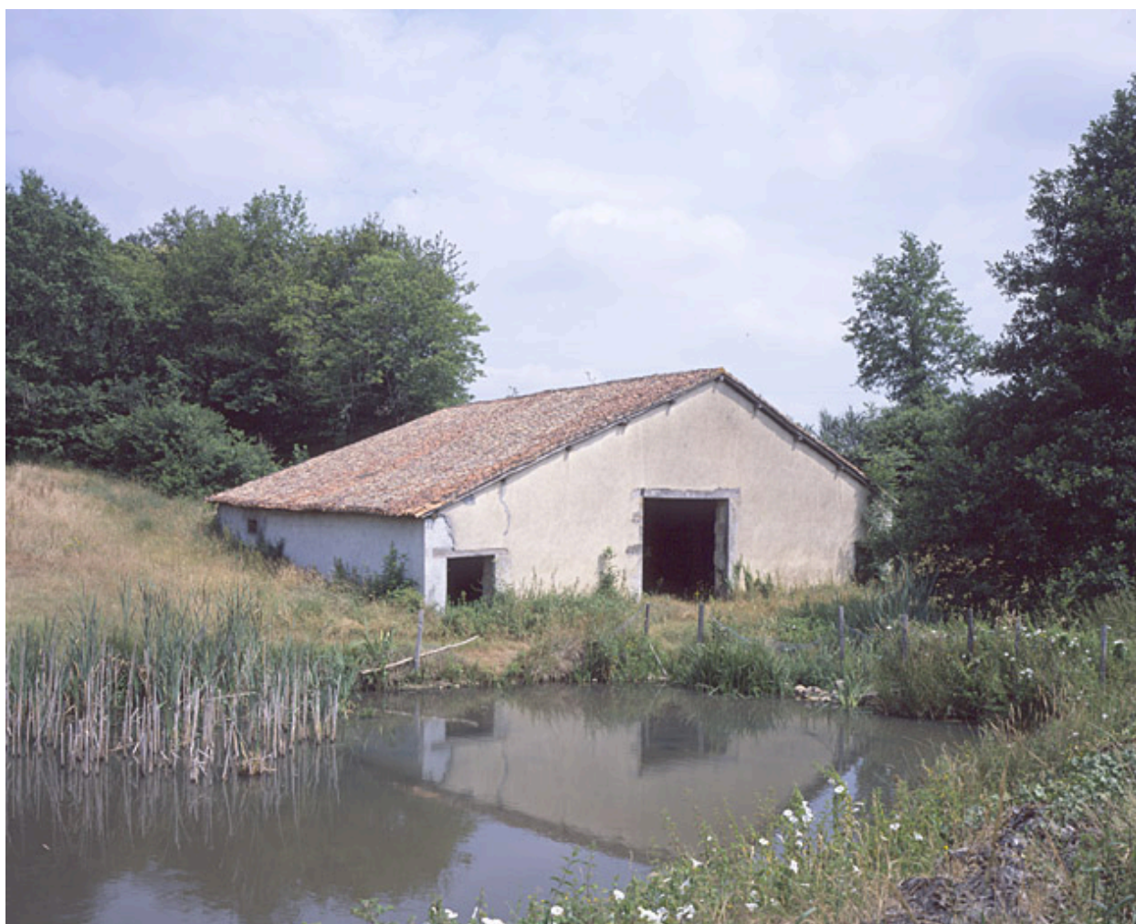
Couverture en tuile creuse sur une grange du Maslandrie à Ambernac.
